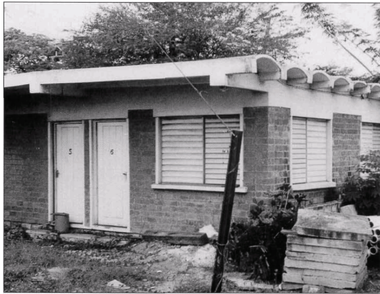
Bild 4: Das BRI-Rotschlamm-Demonstrationsgebäude (1998)
