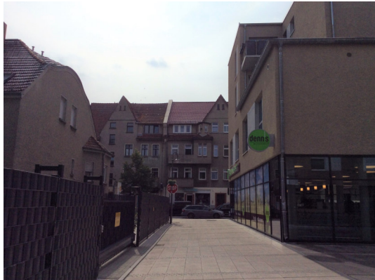
Abbildung 6: Nachverdichtung im Falkenseer Bahnhofsviertel (eigene Aufnahme)
