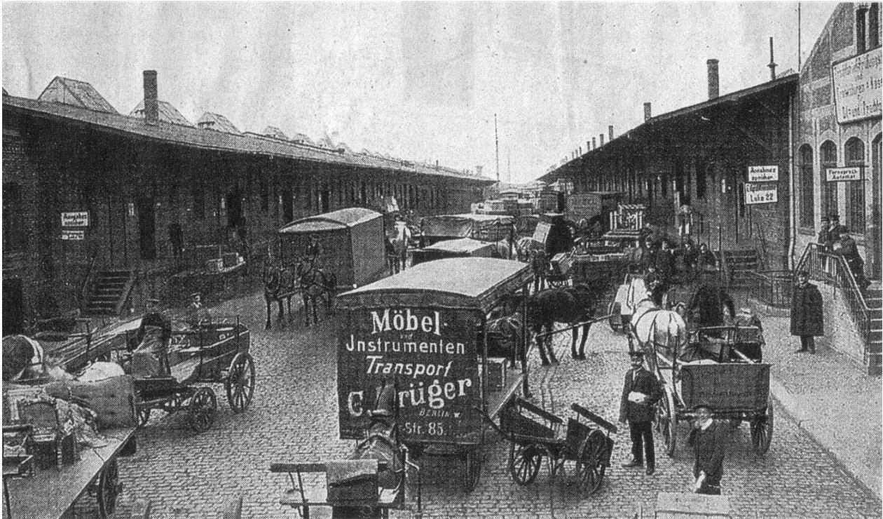
Abbildung 4A: Fuhrwerke an der Ladestrasse des Anhalter Bahnhofs 1911. Quelle: Das deutsche Eisenbahnwesen, Berlin 1911.
