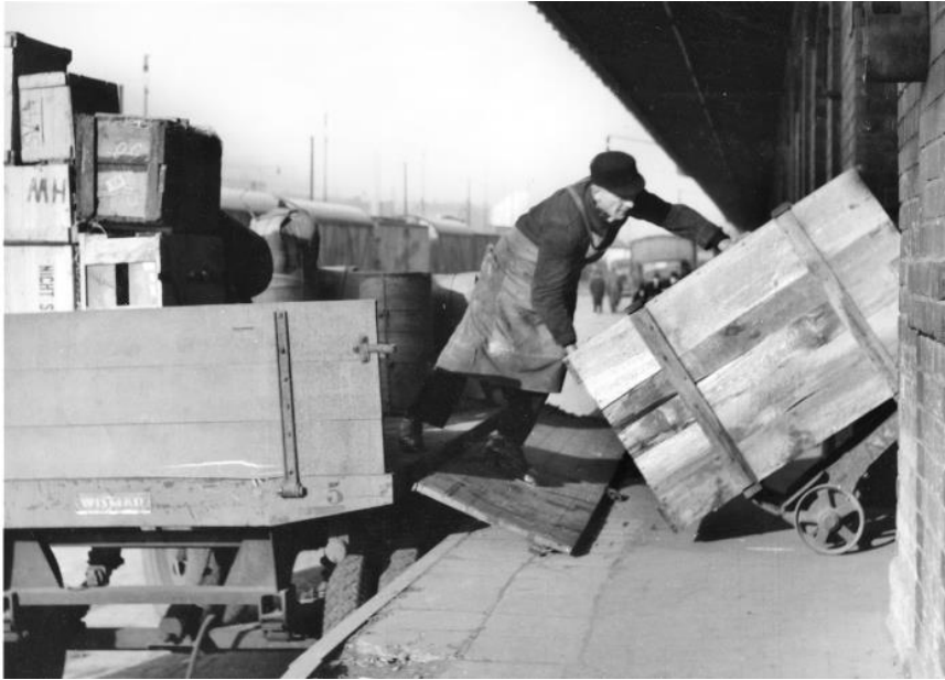
Abbildung 12A. Quelle: Reichsverkehrsministerium, freigegeben von der Eisenbahnstiftung Joachim Schmidt. Man beachte die Beschädigung der Rampe.
