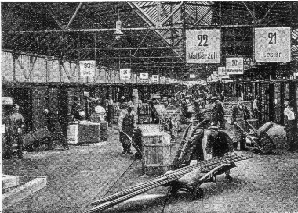
Abbildung 12: Stückgutumschlagshalle mit Transportband im Verschiebebahnhof Magdeburg-Rothensee 1928 (Quelle: Verkehrstechnik 1929, Heft 2, S. 23)
