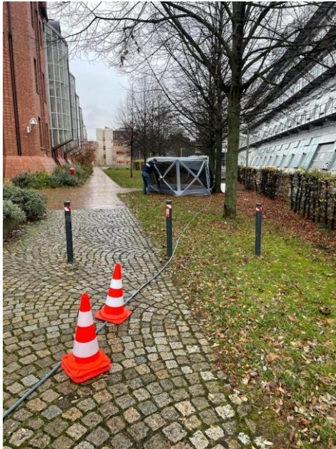
Abb. 26: Sicherung von Pumpschlauch und Stromkabel
