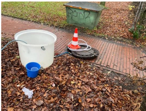
Abb. 27: Abführen des hochgepumpten Wassers in den Kanal
