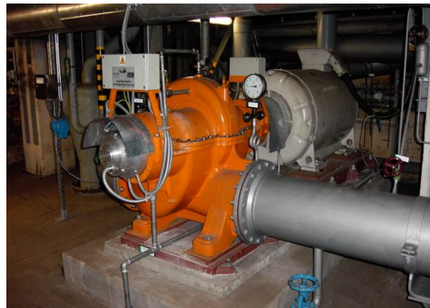
Einbau im Kraftwerk Boxberg
