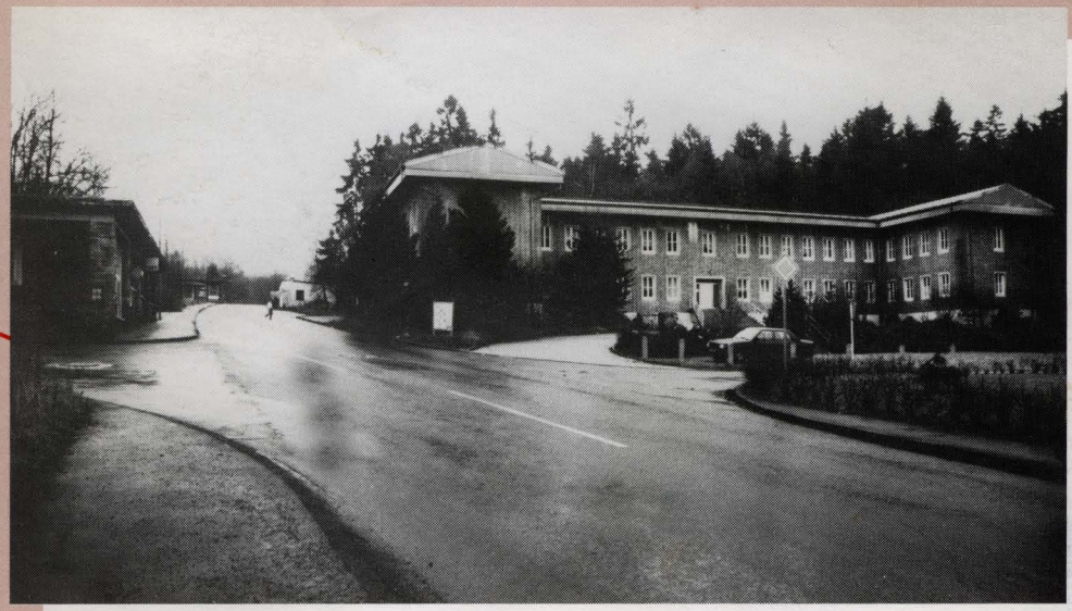
rechts ehemaliges Verwaltungsgebäude der Munitionsfabrik. links ehemaliges Wachhäuschen. Arbeiter(innen) wurden hier beim Betreten und Verlassen des Werkes kontrolliert. »1
