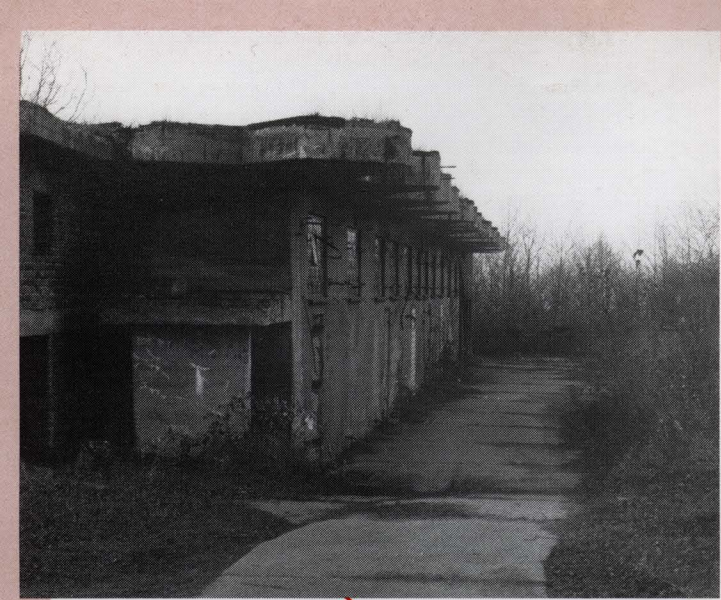
Den Pressen zugeordnetes Fertigmachungsgebäude. »3
