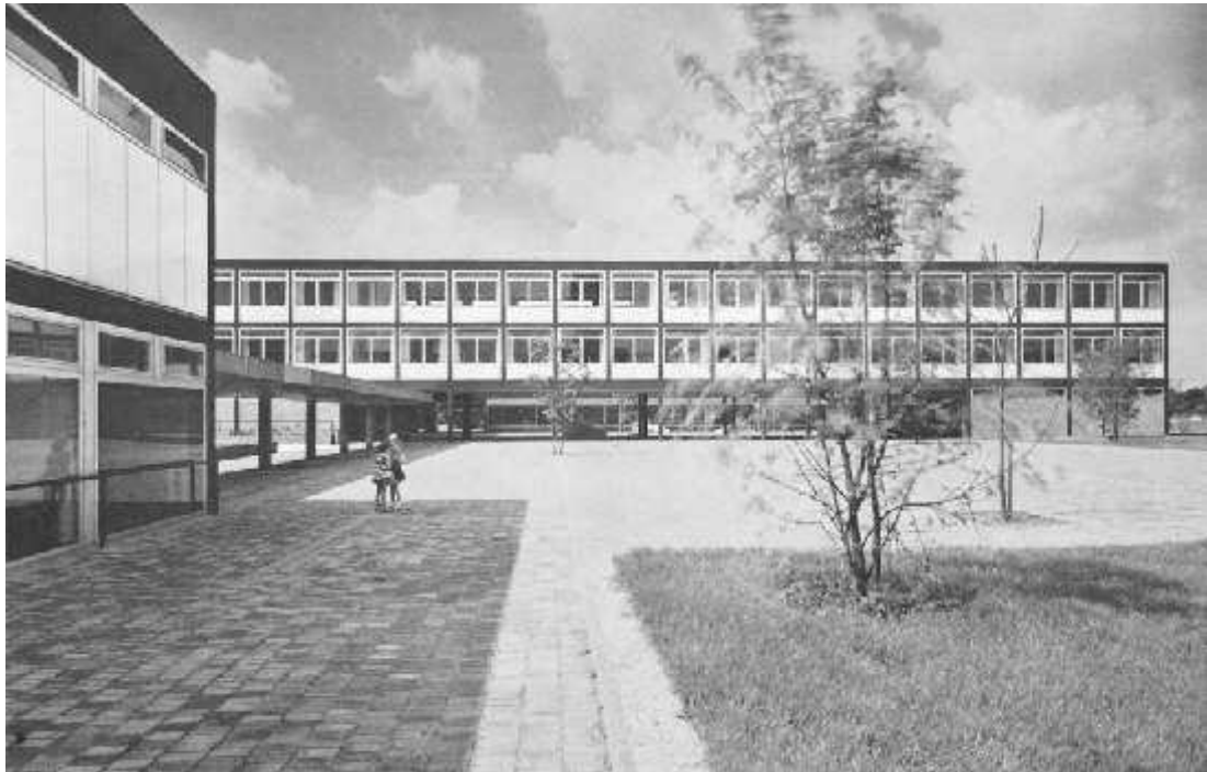
0.25 Volksschule, Rolandstrasse, Düsseldorf, Foto 1958. Architekt: Paul Schneider-Esleben.
