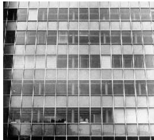
8.5 Fassadenausschnitt, Foto nach 1960.
