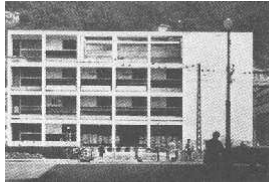
0.13 Casa del Fascio, Como, Schweiz, Foto 1936. Architekt: Guiseppe Terragni.
