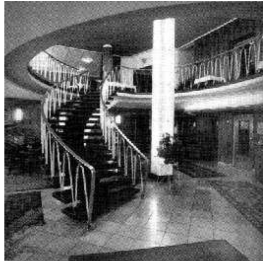
2.6 Treppe, Eingangshalle, Foto nach 1953.
