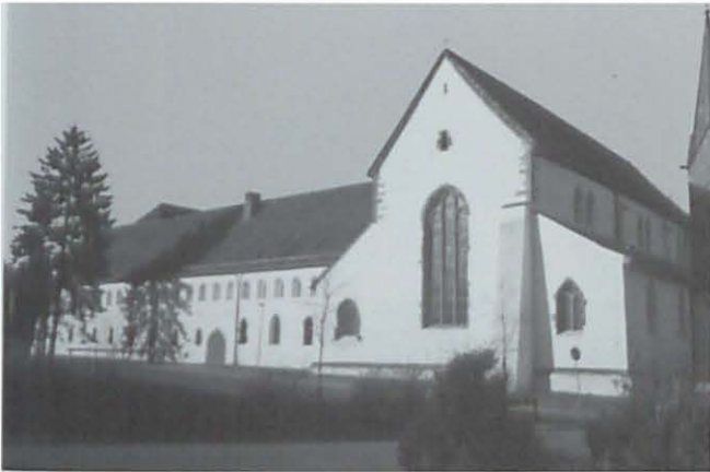
Abb. 1 Brenkhausen, ehem. Zisterzienserinnenkloster, Kirche und Klausurostflügel von Nordosten (Foto: M. Mersch).
