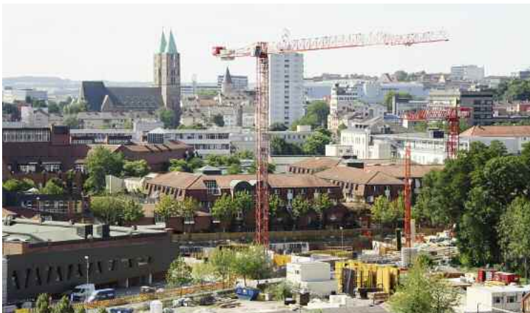
Hier entsteht das neue Hörsaal Campus Center HCC
