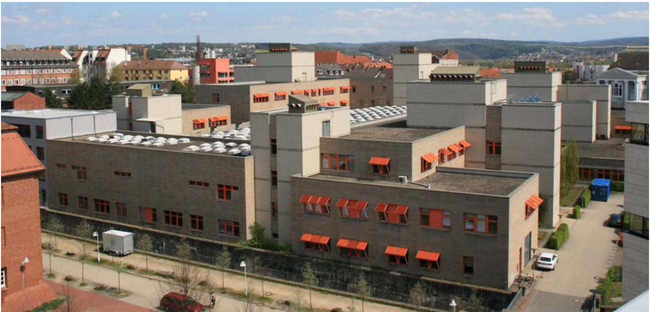
Abbildung 1-1: Süd-Westansicht Gebäude Technik I/2
