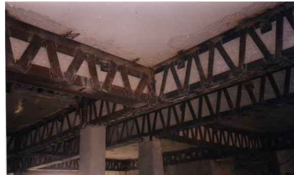
Abb. 1.4: Unterstützung beschädigter Träger
