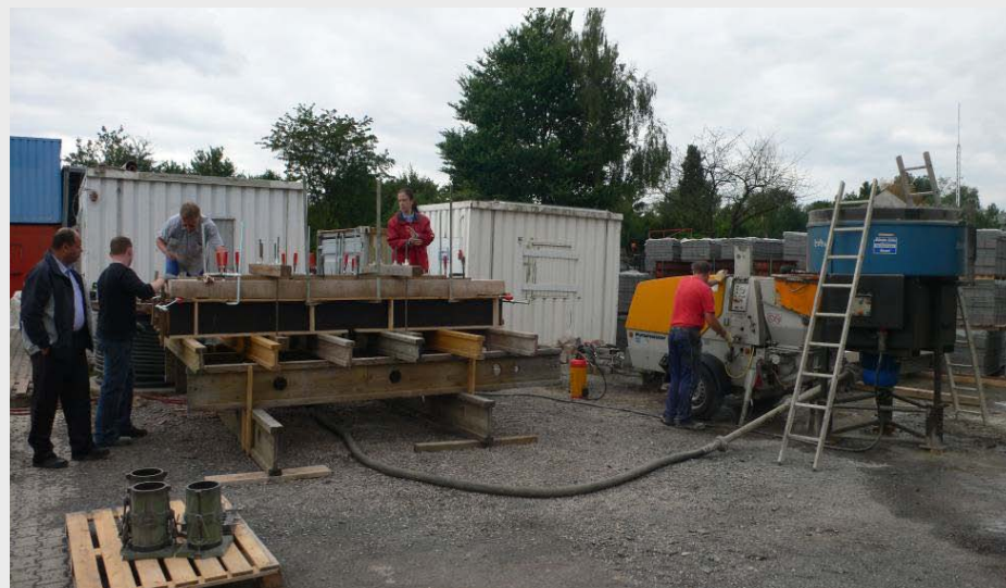
Abb. A2.45: Betonage des UHPCs
