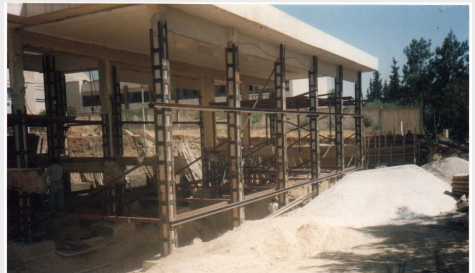
Abb. A2.3: Verstärkung der Balken und Stützen mit Anwendung von Stahlummantelung
