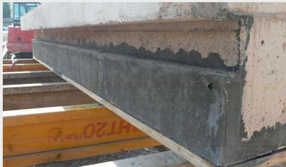
Abb. A2.48: Verstärkung des Normalbetons mit UHPC
