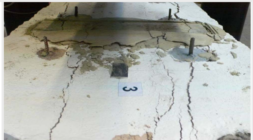
Abb. A2.125: Rissbildung und Versagensbild im oberen Bereich des Balkens
