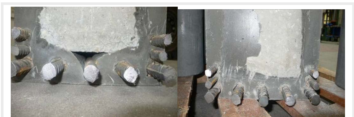
Abb. 5.8: Fotos zur zweiten Variante- links: Bildung einer Luftblase, rechts: Betonage ohne Bildung einer Luftblase
