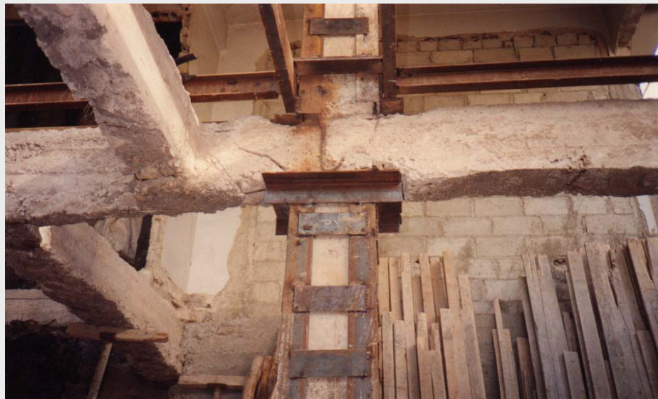
Abb. A2.4: Verstärkung der Stahlbetonstütze in einem leerstehenden Gebäude in Damaskus
