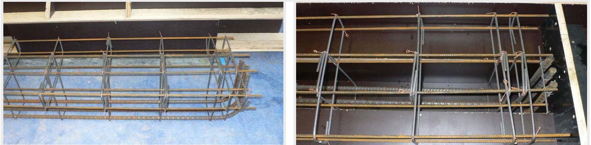
Abb. A2.34: Vorbereitung des Bewehrungsstahls und der Schalungen für die Normalbetonbalken
