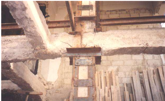
Abb. 1.3: Verstärkung einer schwachen Stütze
