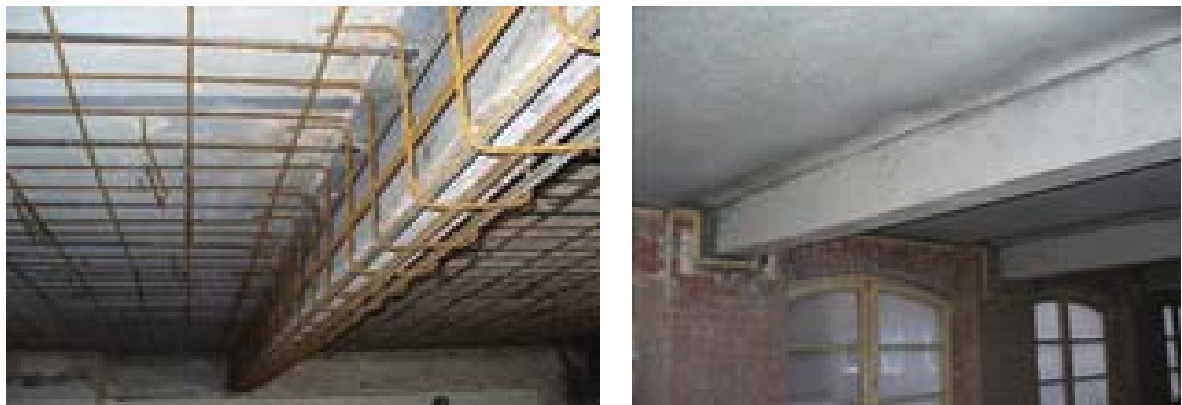
Abb. 3.51: Nachträgliche Bewehrung (l) Verstärkung Unterzug mit Spritzbeton (r). ( www.torkret.de )
