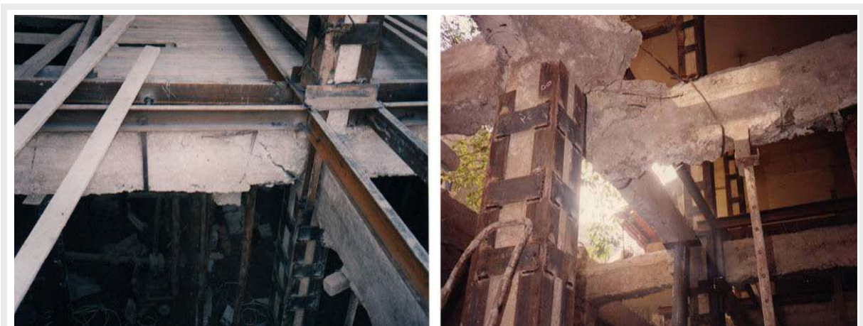
Abb. 3.28: Vorläufige Verstärkung eines Trägers (eigene Fotos, Damaskus, 1996)
