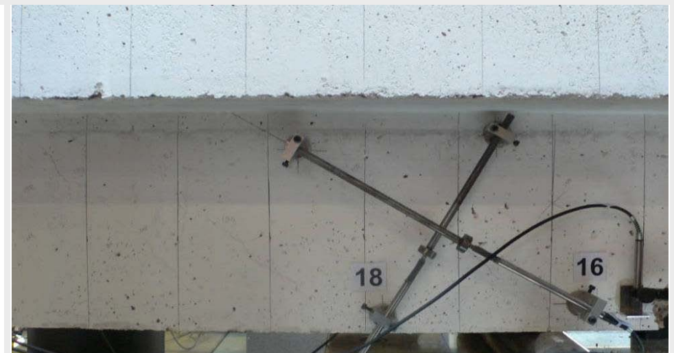
Abb. A2.69: Installation der Wegaufnehmer
