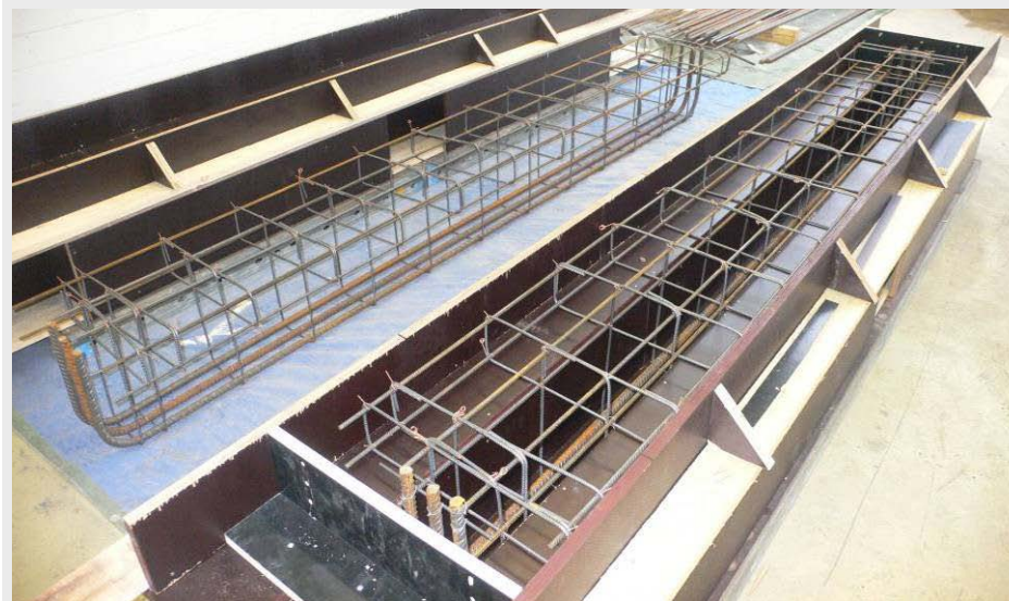
Abb. A2.35: Ausführung des Bewehrungsstahles und Einfüllen des Normalbetons
