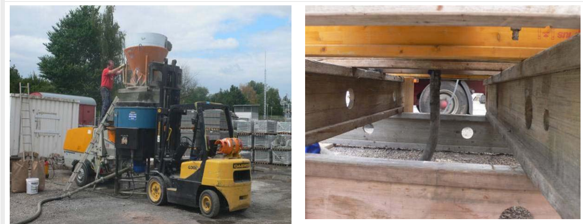
Betonmischer und Betonpumpe bei Fa. W&S
