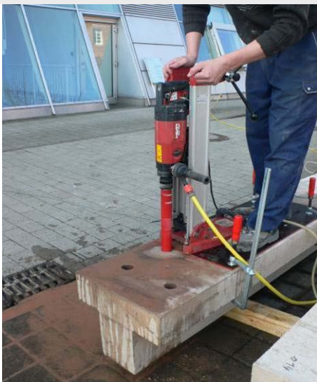
Abb. A2.39: Ausführung von Löchern in den Balken Nr. 6 und 7 um den UHPC einzufüllen und zur Herstellung eines kraftschlüssigen Anschlusses
