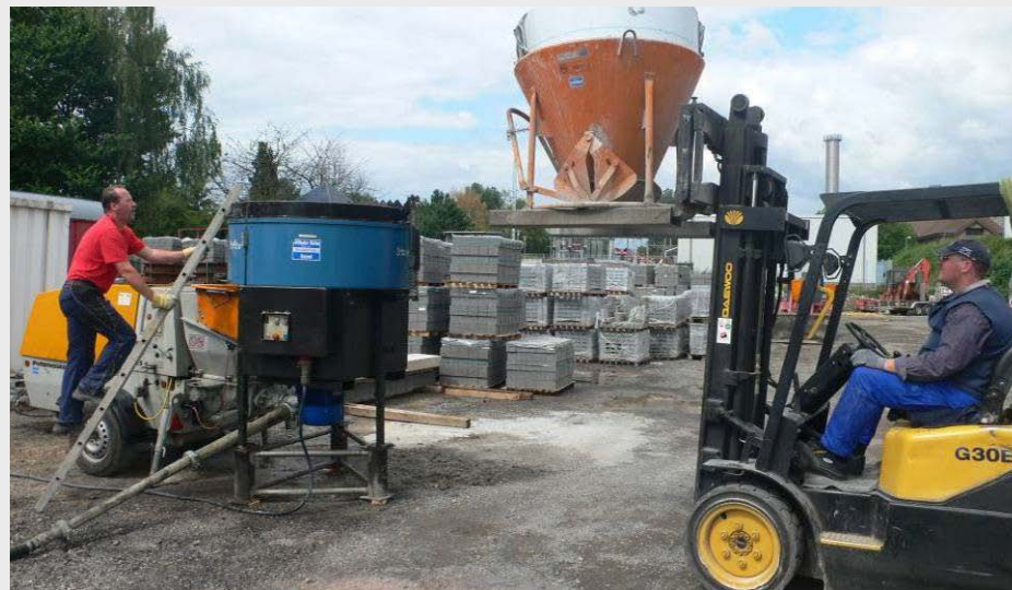
Abb. A2.43: Vorbereitung der UHPC-Mischung
