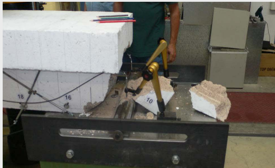
Abb. A2.72: Bruch des Balkens während der Versuchsdurchführung
