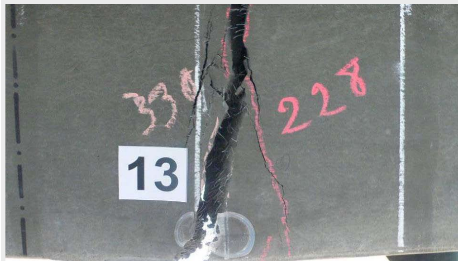
Abb. A2.61: Bildung eines großen Risses
