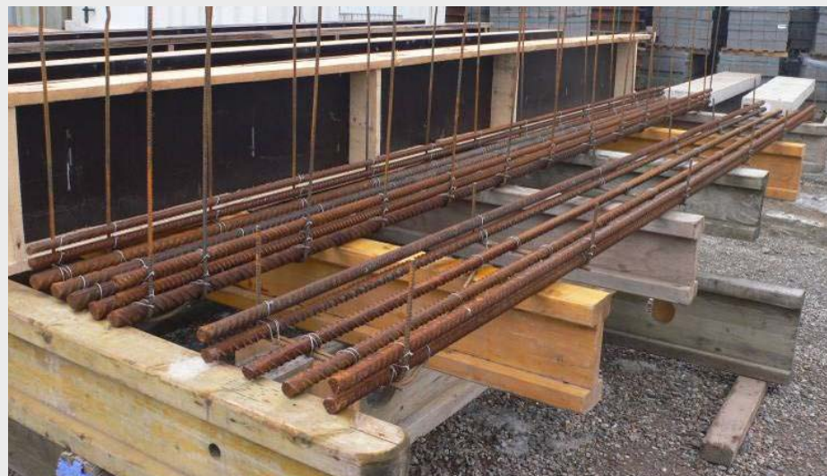
Abb. A2.40: Ausführung des Bewehrungsstahles für den UHPC in der Firma W&S - Kassel
