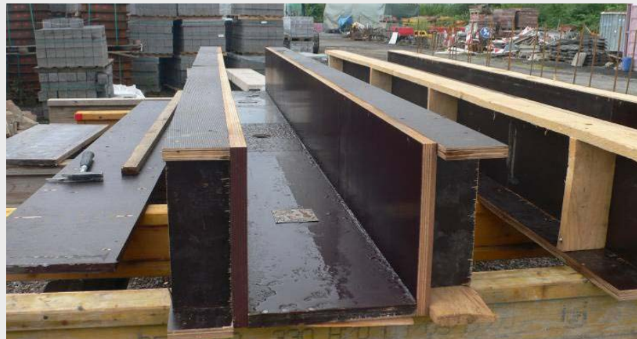
Abb. A2.41: Ausführung der Schalung des UHPCs
