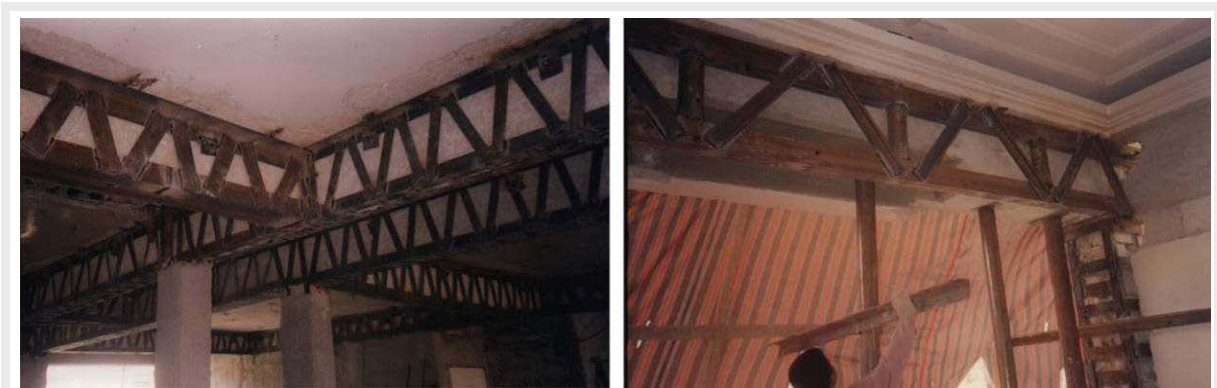
Abb. 3.32: Verstärkung von Balken mit Anwendung von Stahlmantelung (eigene Fotos, 1996)
