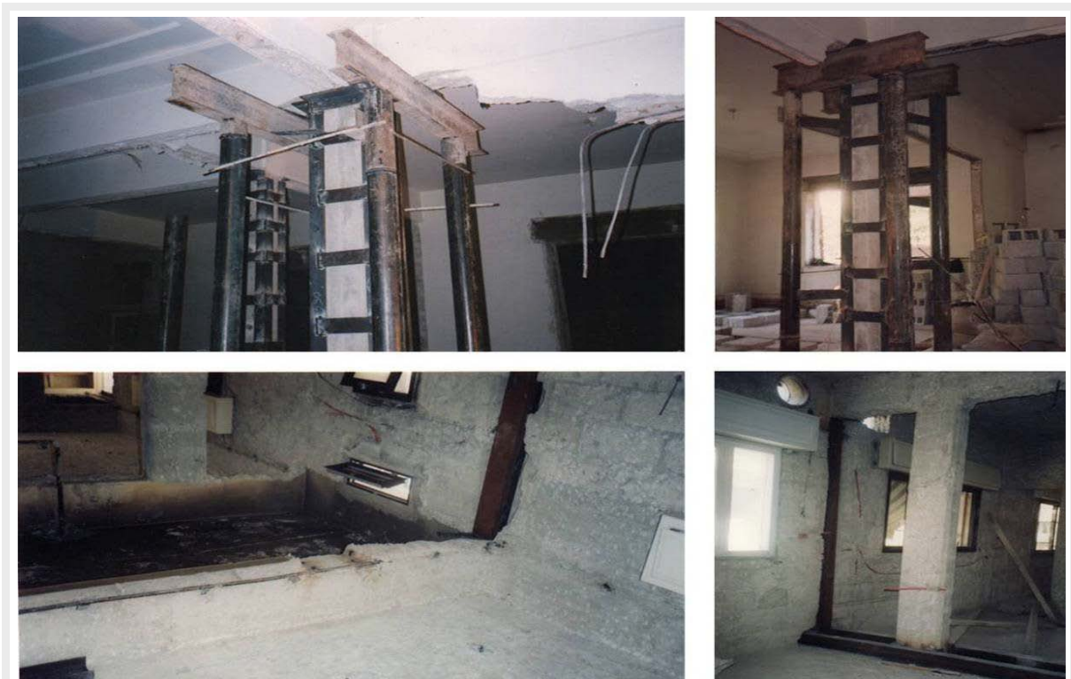
Abb. 3.18: Entfernen und Austauschen der Stütze (eigene Fotos, Damaskus, 1996)
