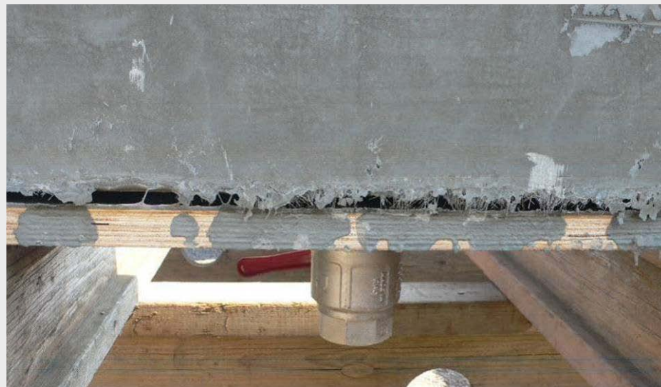
Abb. A2.46: Einpressen des UHPC für die Betonage
