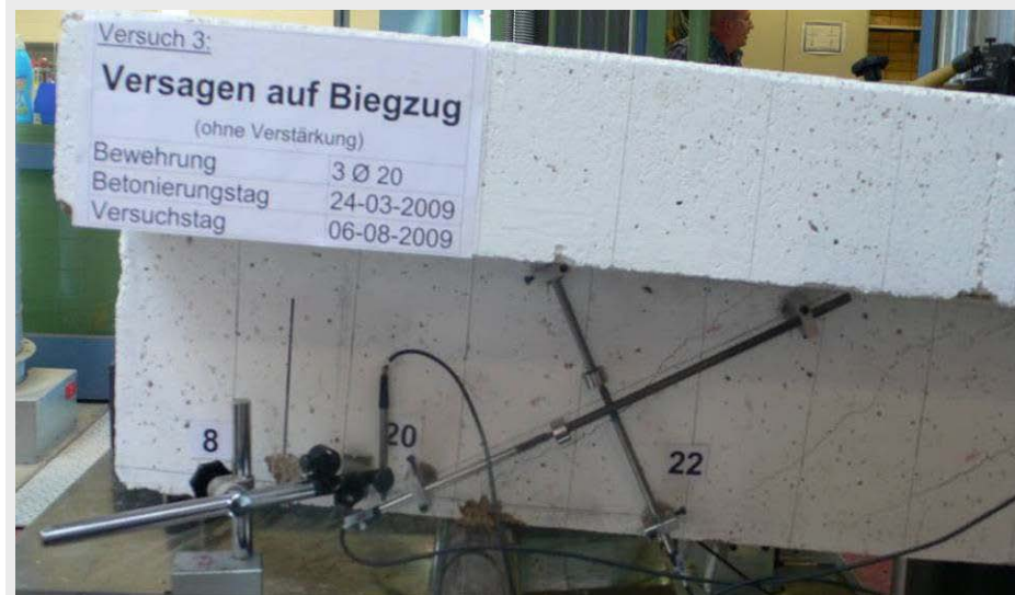
Abb. A2.74: Rissbildung am Auflager
