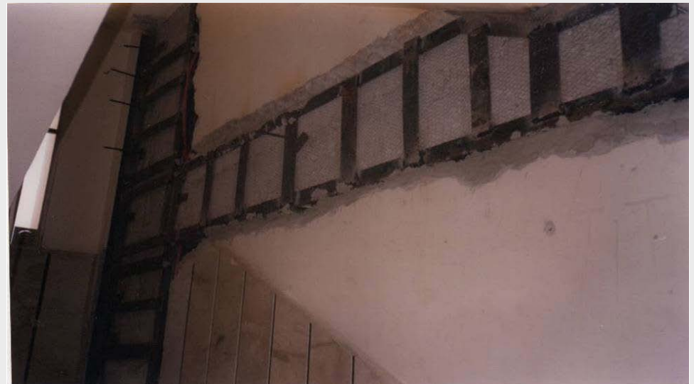
Abb. A2.3: Verstärkung der Balken und Stützen mit Anwendung von Stahlummantelung
