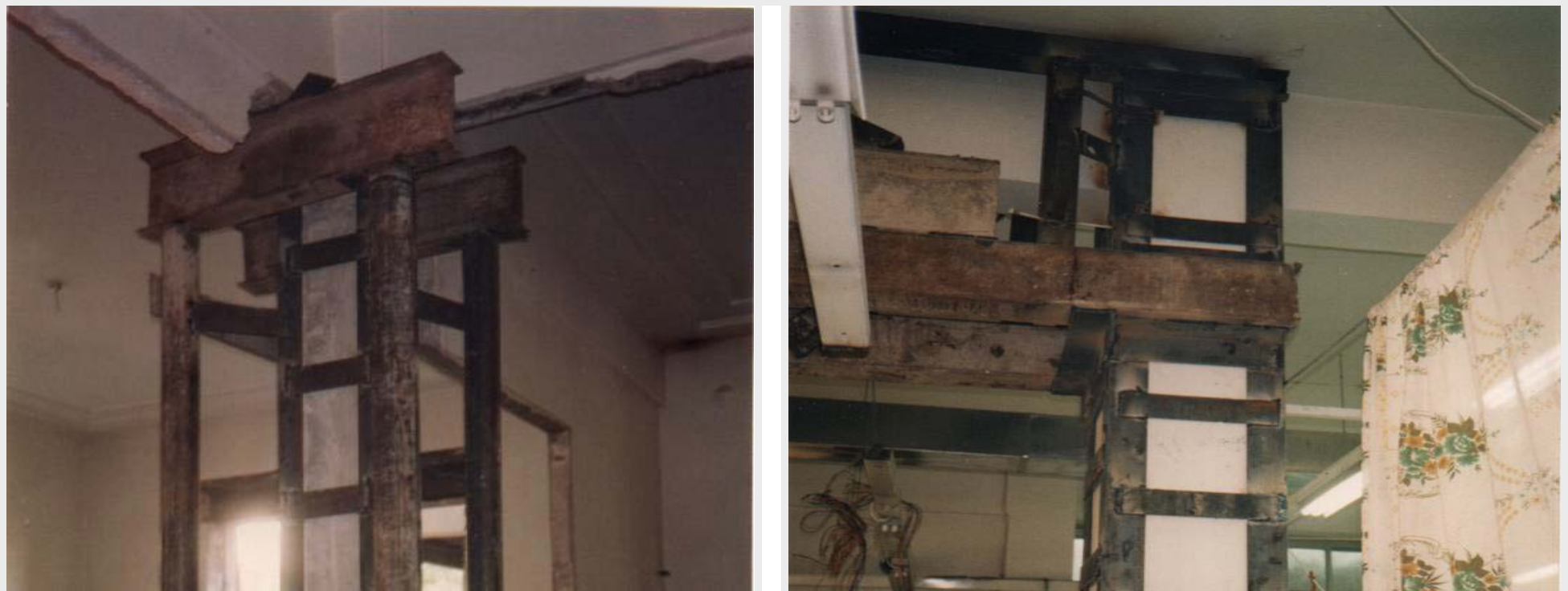
Abb. A2.1: Verstärkung einer Stahlbetonstütze in einem bestehenden Gebäude in Damaskus
