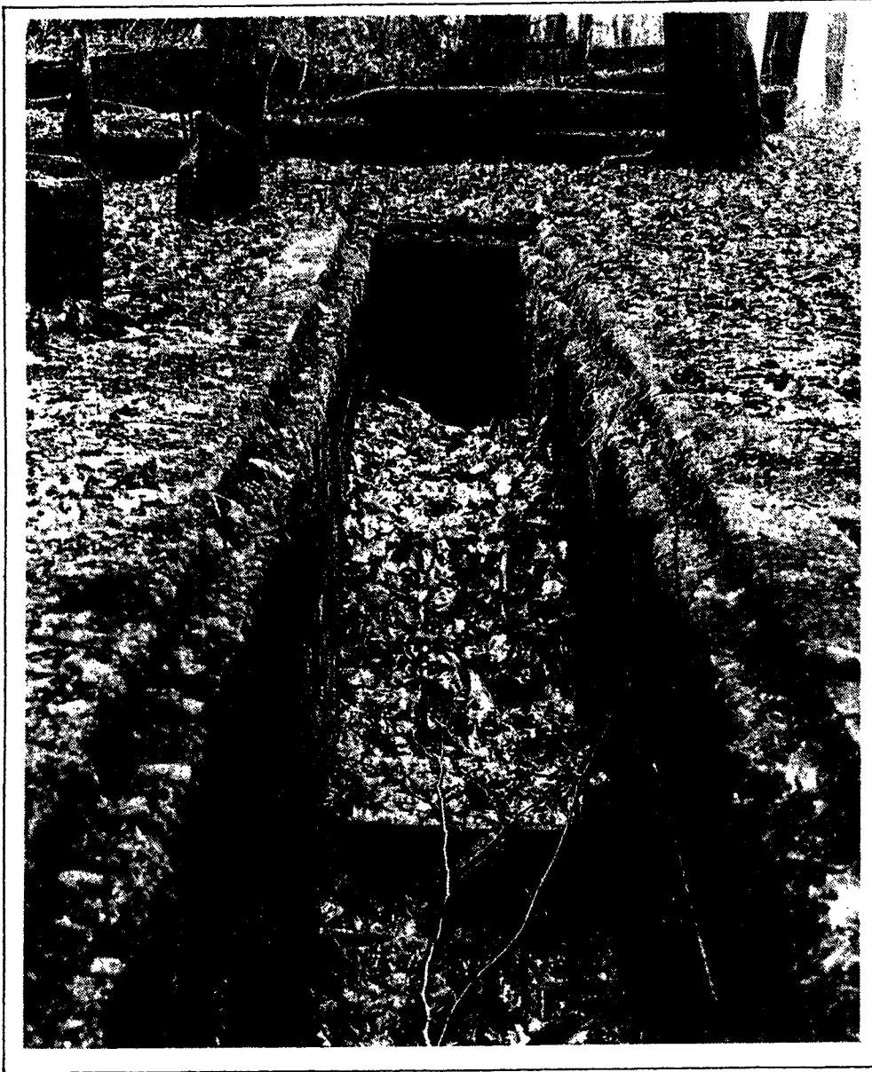
Offene Abwasserkanäle im Bereich der Nitropentaverpressung.
