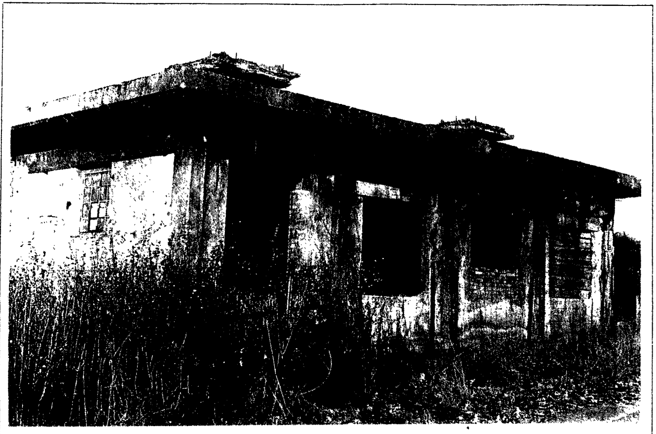
In den ersten Nachkriegsjahren wurden zunächst vor allem Gebäude mit Trinkwasseranschluß zu Wohnzwecken umgebaut. Dazu gehörten auch die ehemaligen Toiletten- oder Abortgebäude.
