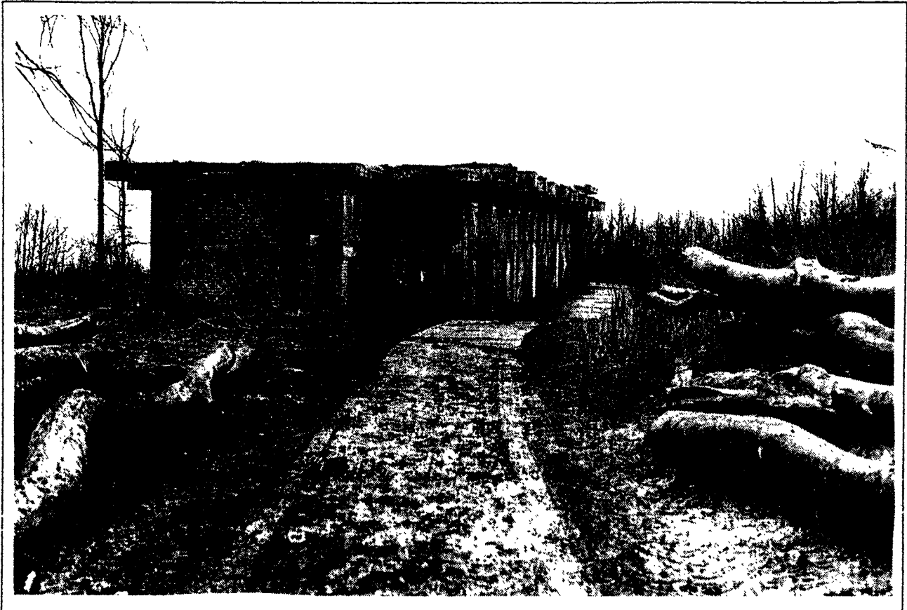
Fertigmachungsgebäude (Nr. 367) am Ende der heutigen Daimlerstraße, zugeordnet der Nitropenta-Betriebsgruppe.
