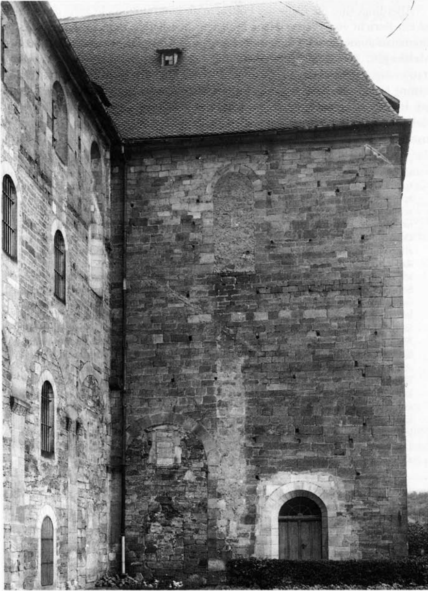
Blick auf den Winkel zwischen Langhaus und Querschiff der ehemaligen Basilika (Foto: Stadtbildstelle Kassel). Man erkennt links die vergitterten Fenster und rechts unten den Eingang zum Gottesdienstgebäude, das aus den beiden Querschiffen und dem Chor besteht.
