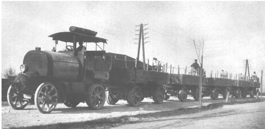
Abbildung 3: Der benzin-elektrische Lastzug von Porsche im Jahre 1914. 29
