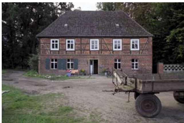
Sanierung alter Bausubstanz
