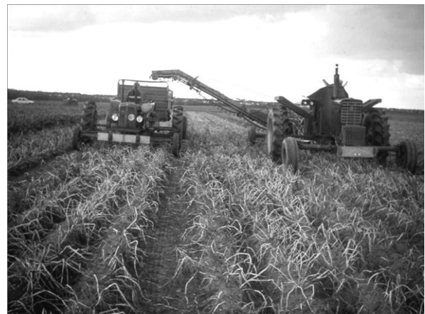
Abb. 2: Links Gantry mit 12m Gesamtbreite und Mähdrescheraufsatz über eine Teilbreite. Rechts Traktoren mit verbreiterter Spur im holländischen Gemüsebau, vermutlich Ende der 1960er, Anfang 1970er. Quellen: Chamen, Vermeulen
