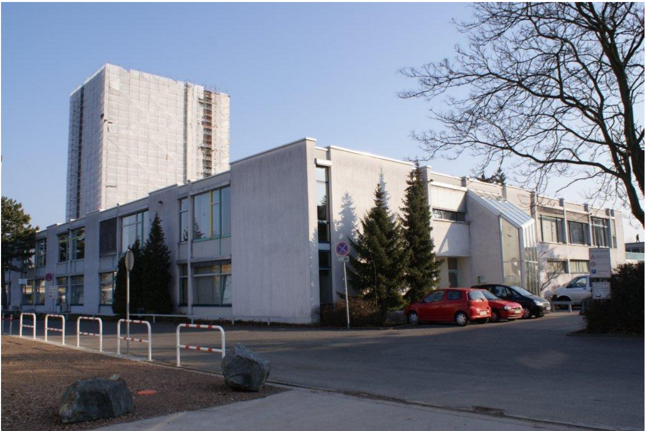
Abbildung 1 – 1: Südwestansicht auf das Gebäude C12, Darmstadt
