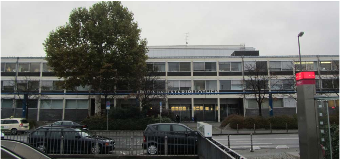
Abbildung 1 – 1: Südwestansicht auf das Gebäude C12, Darmstadt
